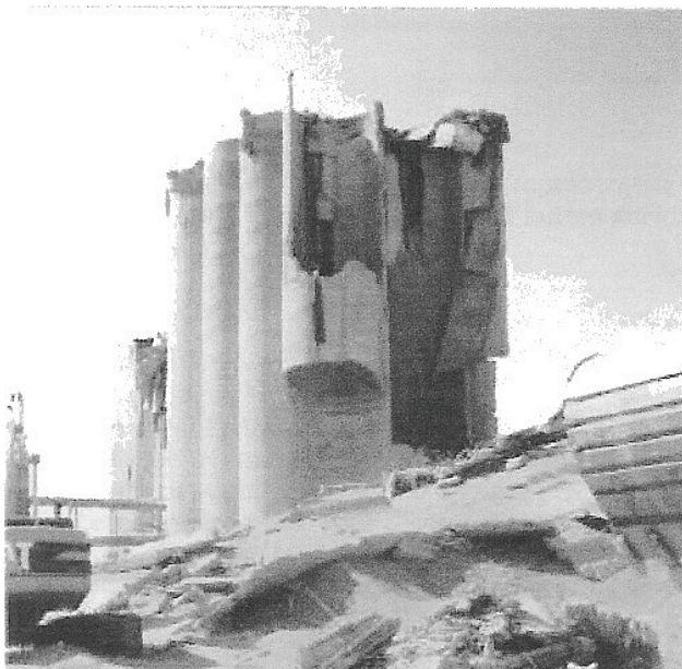
Un exemple d'une explosion dramatique, celui du silo de Blaye : le 20 août 1997, sur les bords de la Gironde, une explosion détruisait un silo à céréales, tuant onze personnes.
